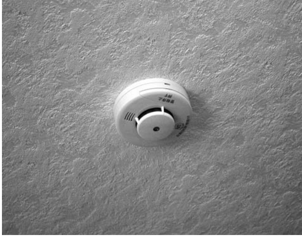
設置が義務づけられる火災警報器
